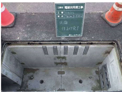
内面仕上げ完了
