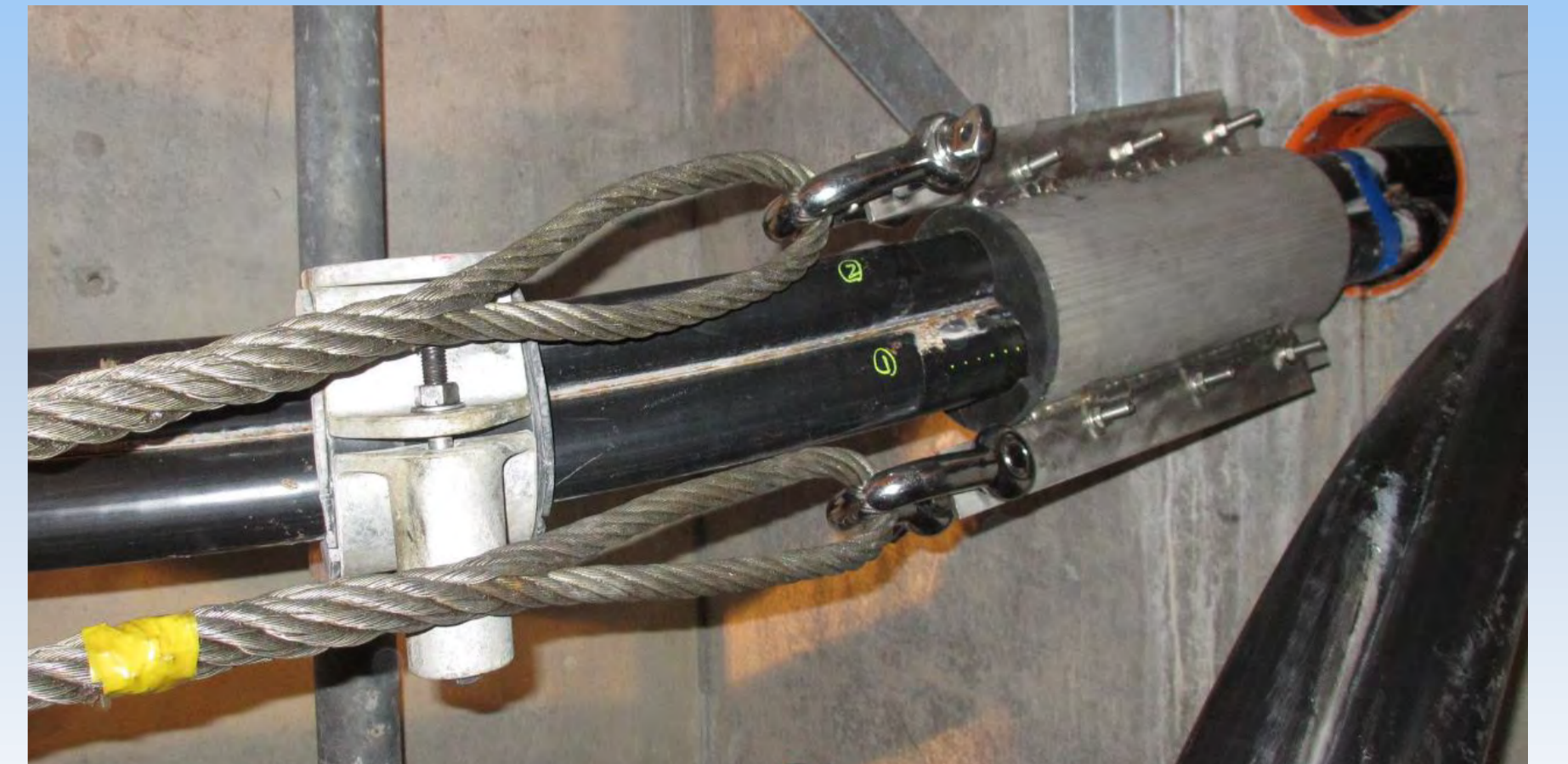
CVTケーブル引戻し装置使用状況
