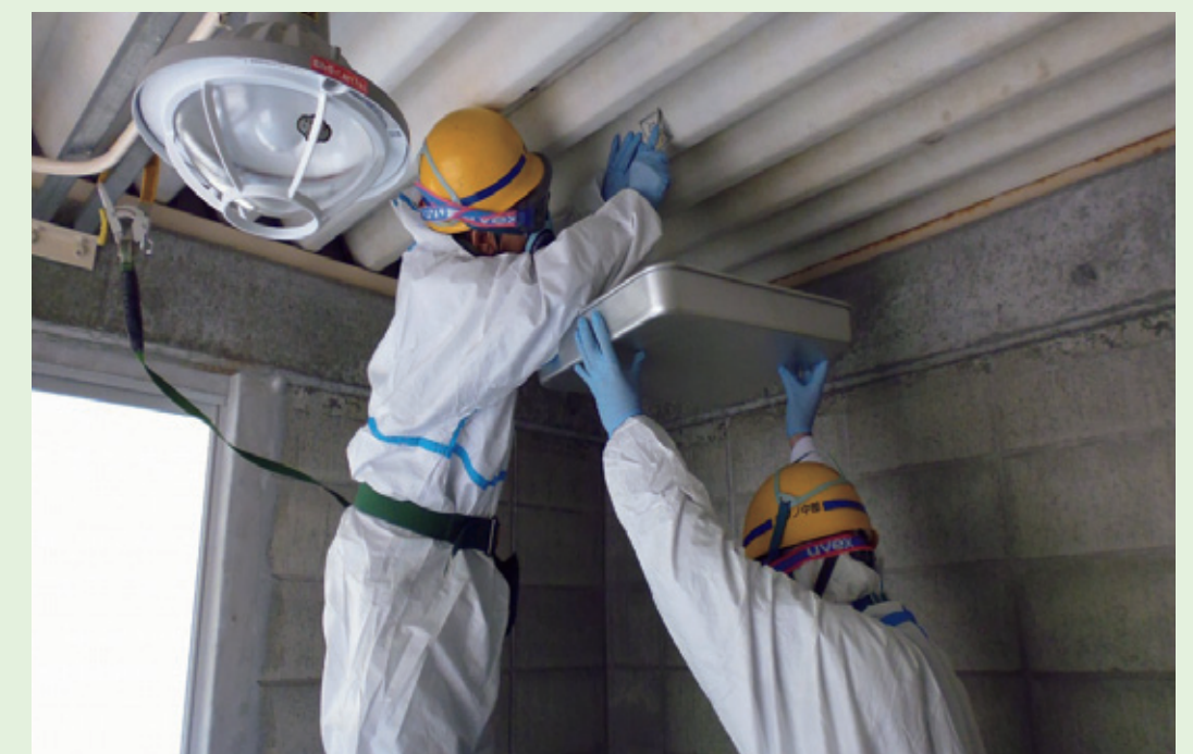
建材中の石綿試料の採取
