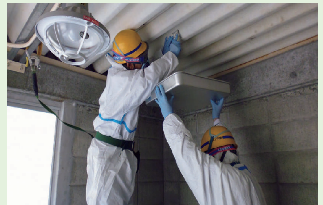
建材中の石綿試料の採取
