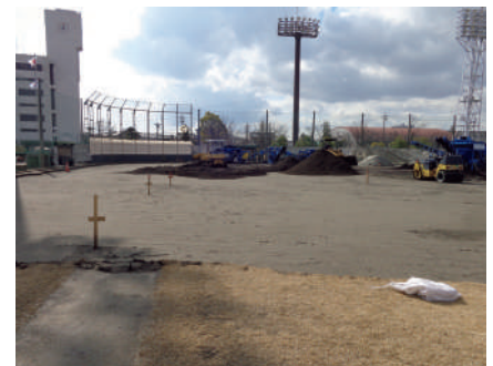
ランドグラスを使用した野球場の施工状況
