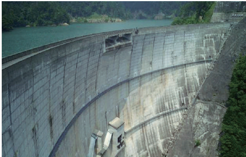
フライアッシュセメントを使用した中部電力川浦ダム
