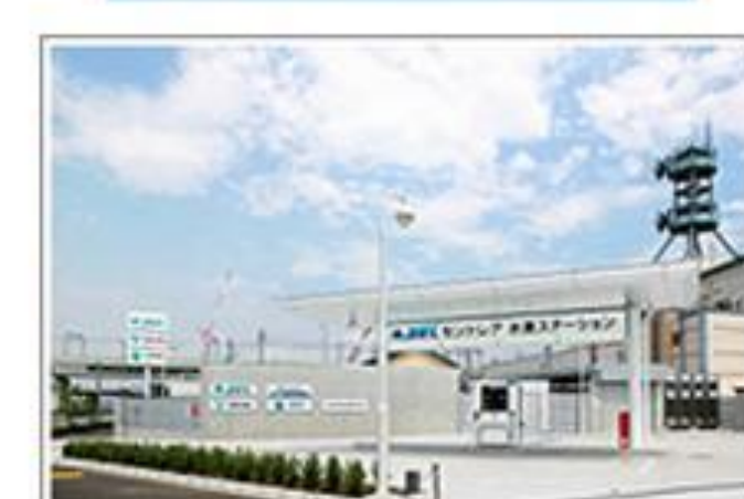
水素ステーション
