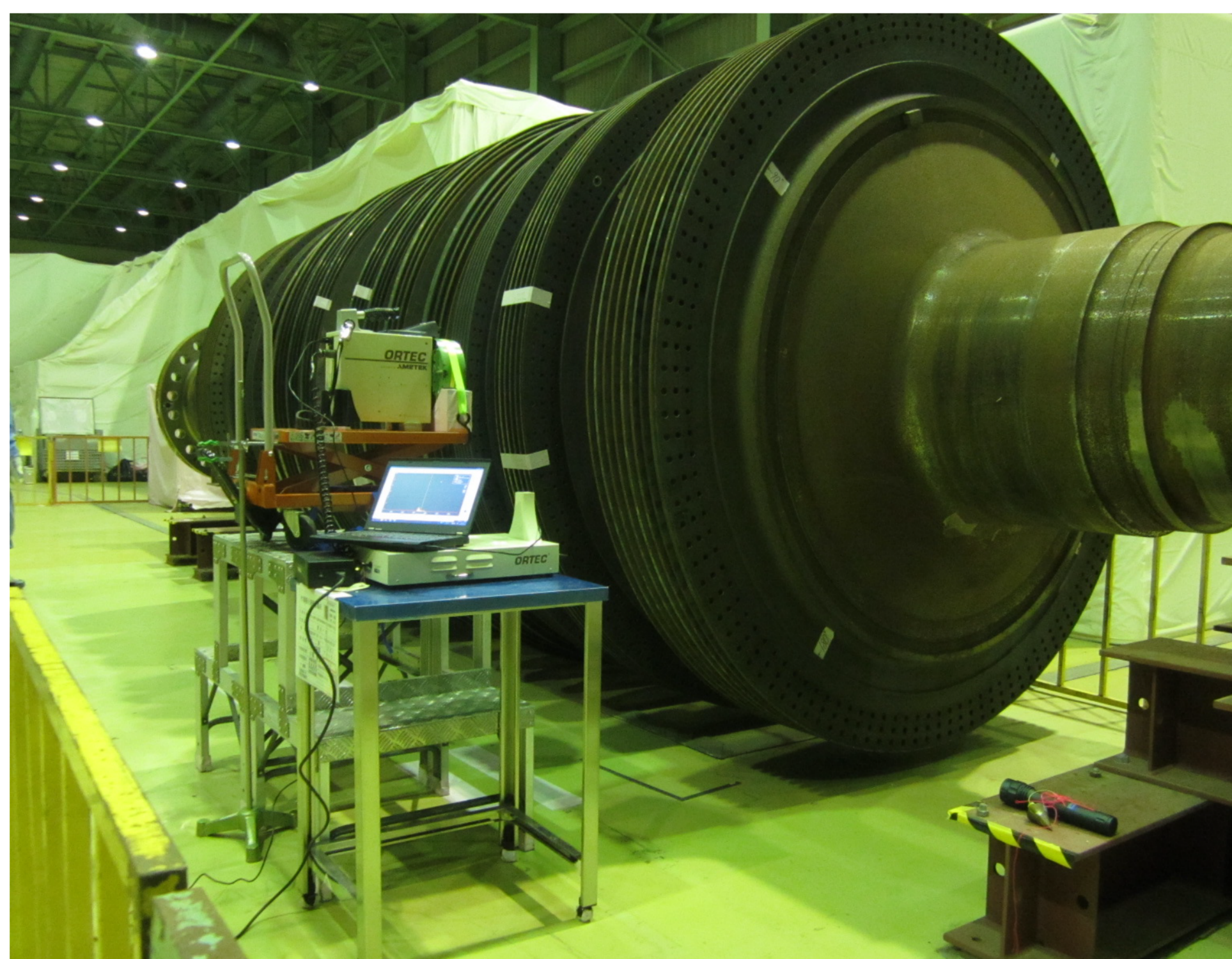
タービン低圧車軸のクリアランス測定
