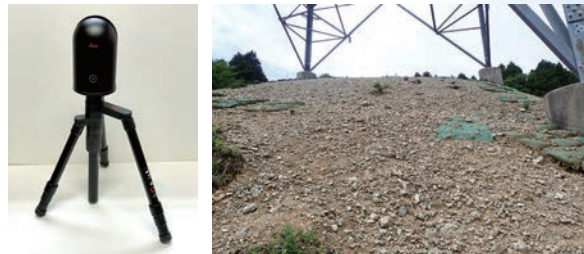
第4図 BLK360(左)と表面侵食が進行している鉄塔敷(右)
