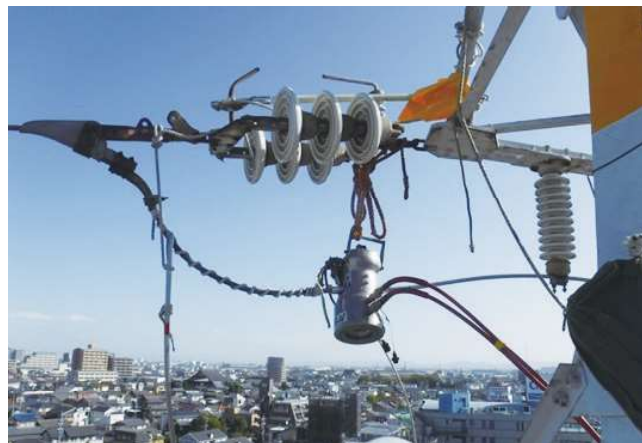
第1図 圧縮形接続管の塔上圧縮作業状況
