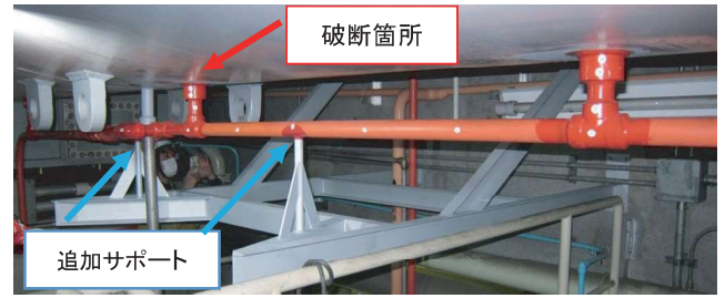
第8図 実機での検証例（対策後）
