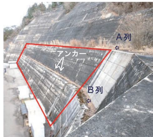
第2図 調査対象法面
