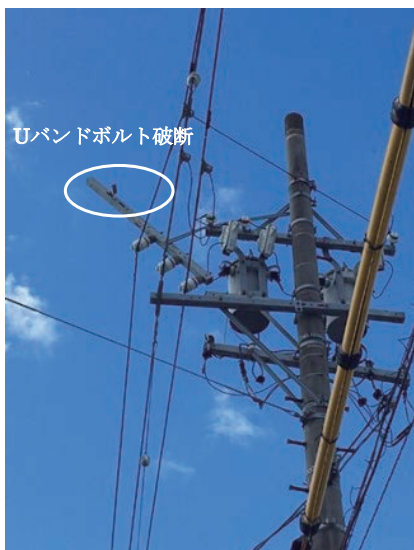
第1図 Uバンドボルト破断事象
