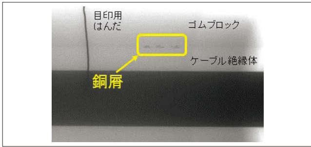
第2図 77kV用ゴムブロック試料の撮影結果の例
