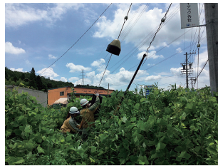
第2図 取付作業性検証
