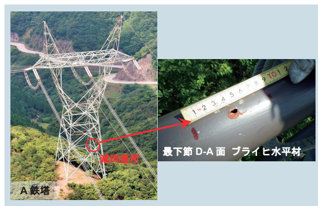
第1図 鉄塔外観および減肉による孔
