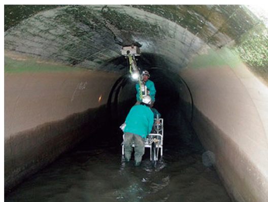
第1図 トンネル覆工背面の空洞調査の例
