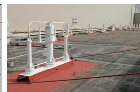
第2図 設置状況
