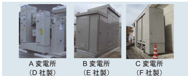
第3図 新形C-GIS据付状態
