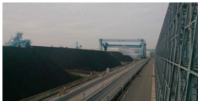
第1図 当社碧南火力発電所 貯炭場
