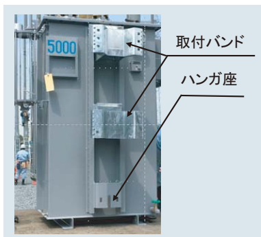
第1図 取付バンドの装柱
