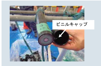
第3図 解体状況
