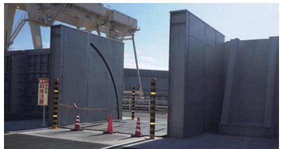
第5図 車両用ゲートの現地設置状況
