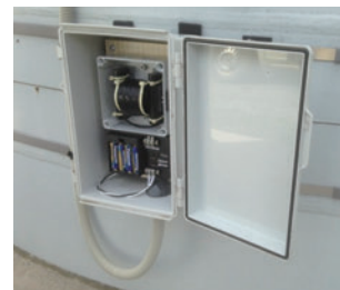
第2図 ソレノイド型の雷撃検出装置
