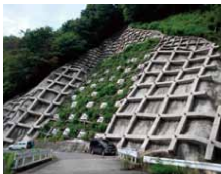
写真2 調査対象アンカー法面
