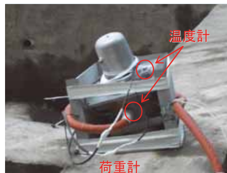
写真3 荷重計と温度計の設置状況
