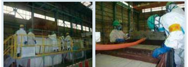
第6図 碧南火力発電所脱硝触媒の化学洗浄時の作業状況
