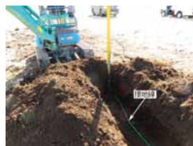
第3図 接地線埋設状況
