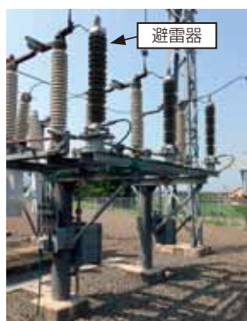
第1図 避雷器の断路器架台上への設置
