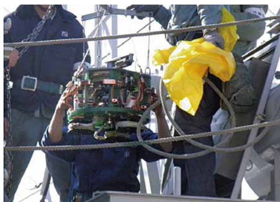
第5図 既設品の切換開閉器取替作業風景
