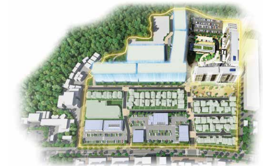
千里藤白台プロジェクト(大阪府吹田市)～商業施設・マンション等を一体開発～
