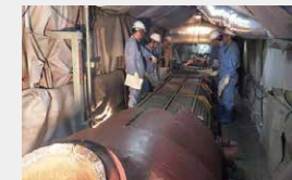
解体現場教育
