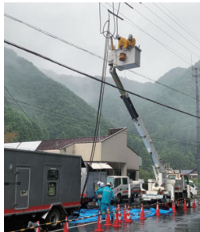
高圧発電機車による災害復旧作業
