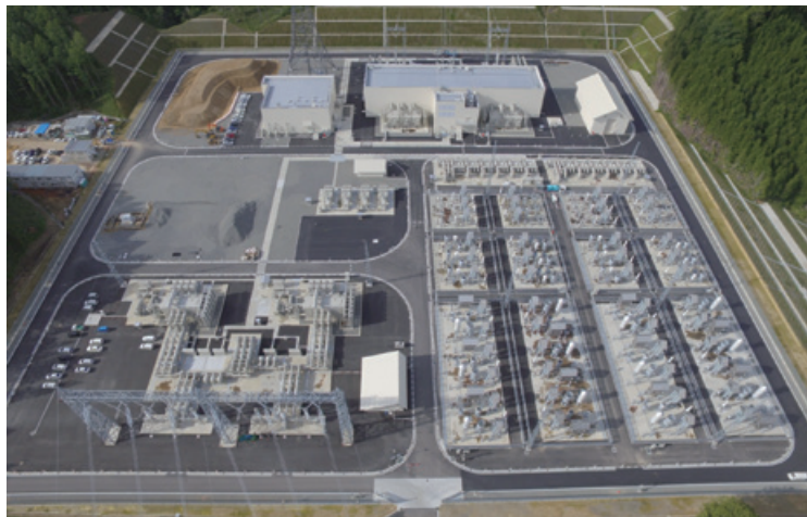
東京中部間（50・60Hz地域間）を連系する飛騨変換所（容量90万kW）
