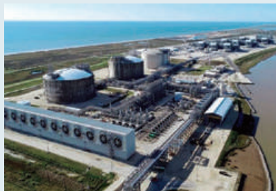
フリーポートLNGプロジェクト液化設備(米国) (FLNG Development社提供)
