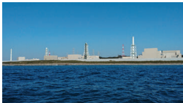
浜岡原子力発電所
