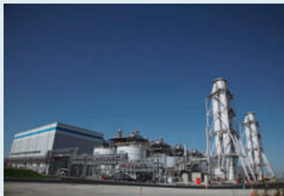
西名古屋火力発電所
