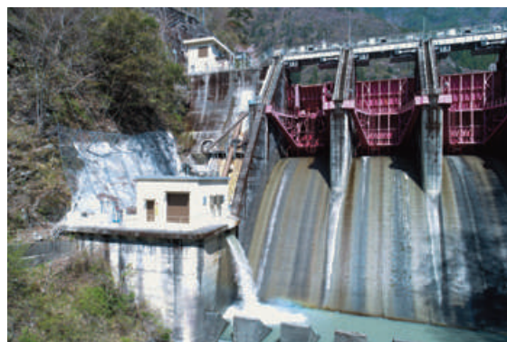
ダムの落差と放流水を利用した維持流量水力発電所を開発 (写真中央建屋：新奥泉水力発電所)
