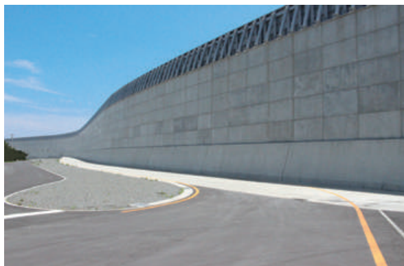
発電所前面に設置した防波壁（海拔22m 全長1.6km）
