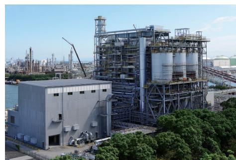
四日市バイオマス発電所
