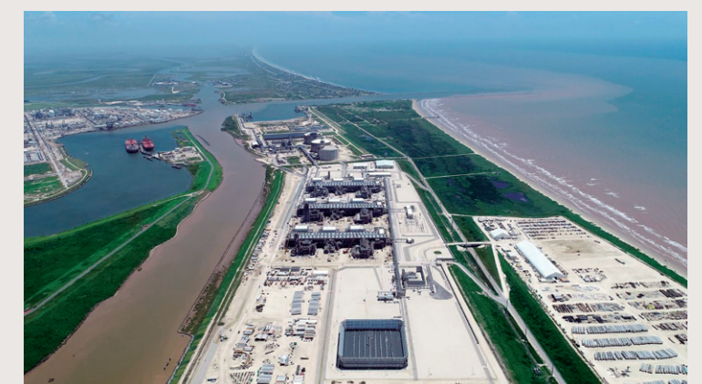
フリーポートLNGプロジェクト液化設備の外観 (FLNG Development社提供)
