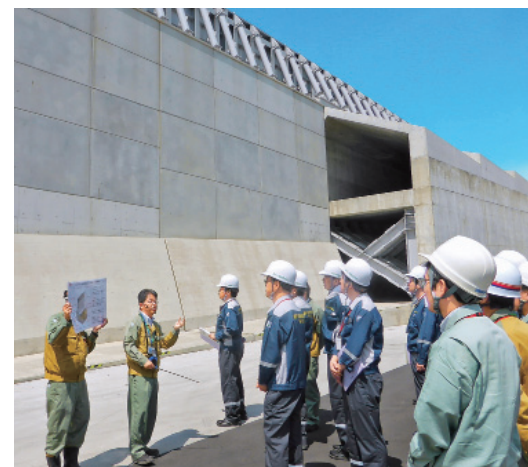
原子力規制委員会の現地視察(防波壁)
