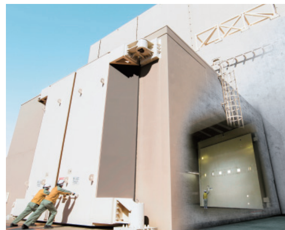
強化扉・水密扉の設置
