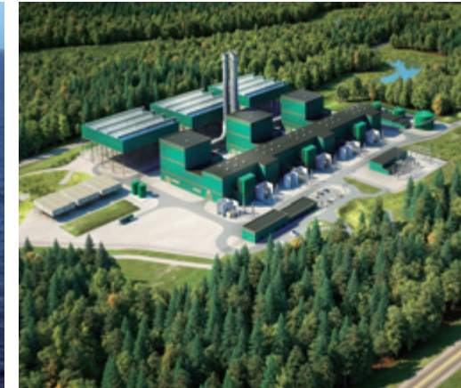
米国ガス火力発電事業（クリケットバレー）
