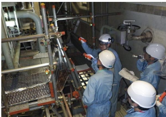
追加で設置した配管および弁の点検の様子
