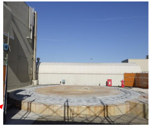
排気筒基礎部(解体後)
