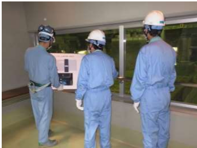
使用済燃料プール水位・水温監視装置設置工事点検の様子
