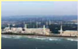
■ 浜岡原子力発電所
