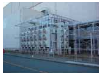
解体する主要変圧器（1号機の例）
