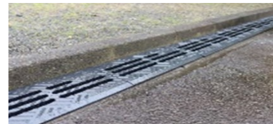
クリアランス物のうち側溝用鉄製蓋 への加工が完了したもの
