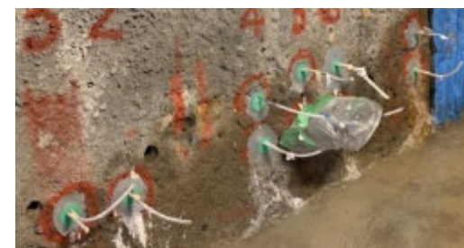
注入孔へのコンクリーション化剤の注入
