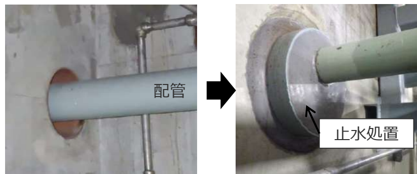
止水処置 (配管)
