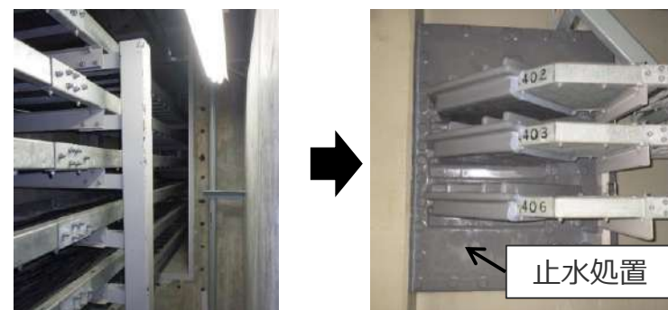
止水処置 (電路)
