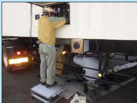
交流電源車操作訓練
