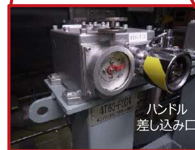
クランクハンドル又は電動工具を接続し操作実施
