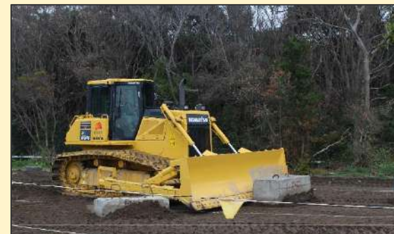
瓦礫撤去訓練
