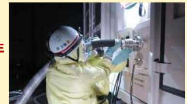
夜間訓練（窒素供給車両への電源接続）の様子 reserved.
