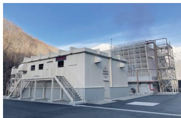
中尾地熱発電所
