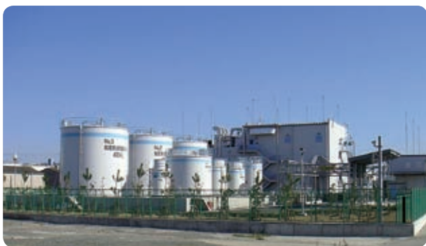
絶縁油リサイクルセンター
