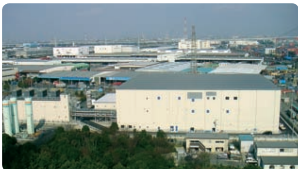
変圧器リサイクルセンター
