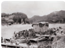
大いかだによる発電機の運搬(建設時)
