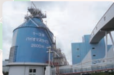
木質バイオマス燃料混焼設備(碧南火力発電所)
