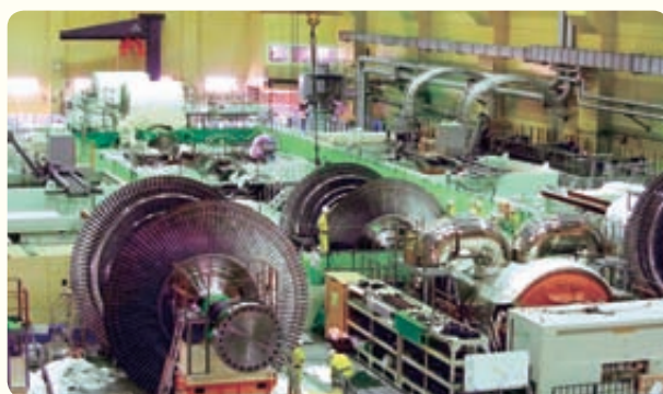
低圧タービン取替作業を行う5号機
