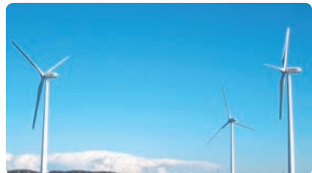
御前崎風力発電所(第1期)
