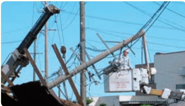
トーエネック従業員による復旧作業(三重県津市)
