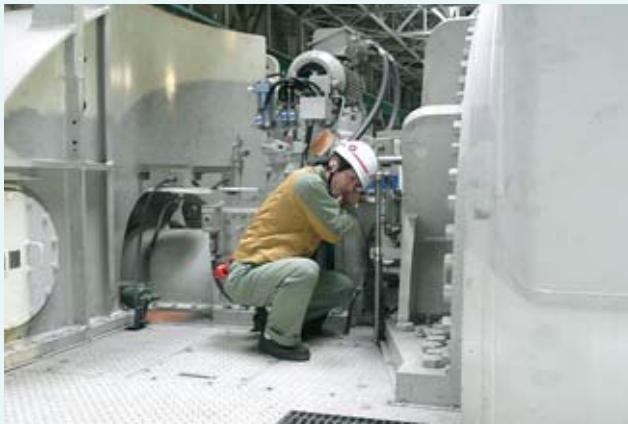
川越火力発電所での巡視・点検作業
