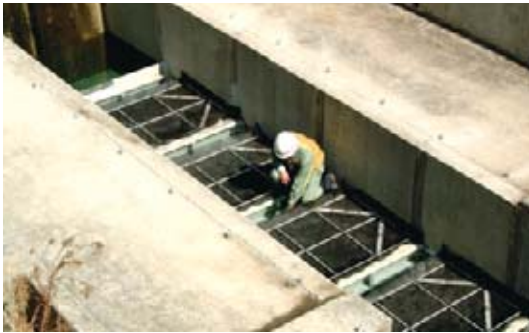
シーキュラスを使用した自治体射撃場の鉛含有排水浄化設備
