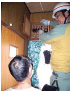
お年寄り宅の配線診断を行う配電技術サービス担当
