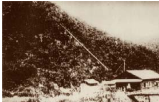
建設当時の岩津発電所
