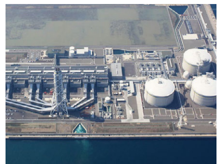
上越火力発電所の全体像(新潟県上越市)
