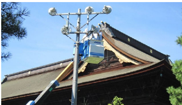
善光寺(長野県長野市)の電気設備点検(電気工事協会の、中部電気保安協会と合同で実施)
