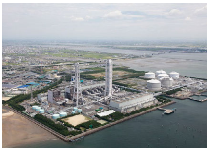
川越火力発電所(三重県川越市)
