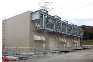
ガスタービン発電機建屋
