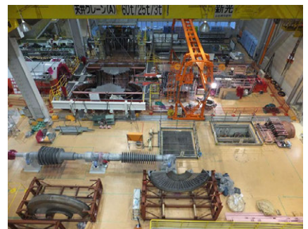
定期点検風景
