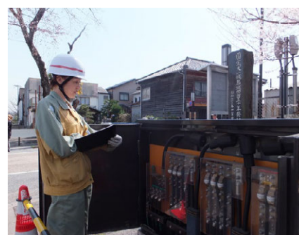
地中配電設備の機器点検
