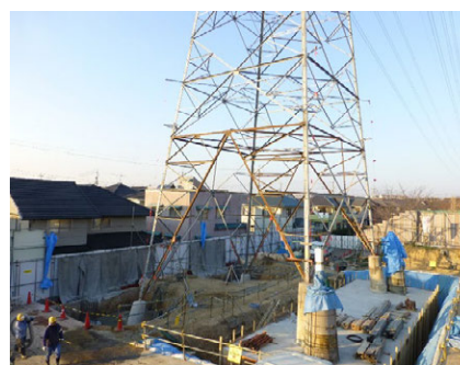
住宅地内での基礎工事
