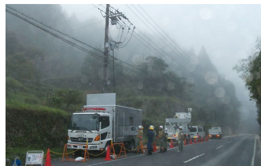
高圧発電機車を使った災害復旧
