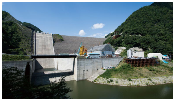
建設工事中の徳山水力発電所(岐阜県揖斐郡揖斐川町)
