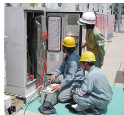
変電設備の点検作業
