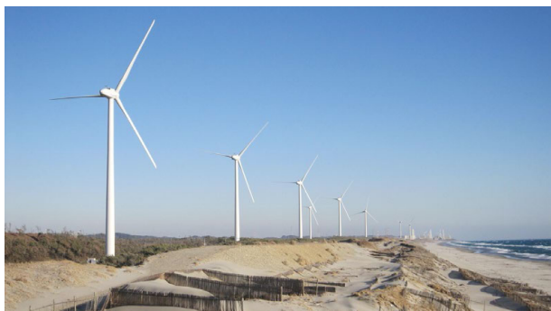
御前崎風力発電所(静岡県御前崎市)
