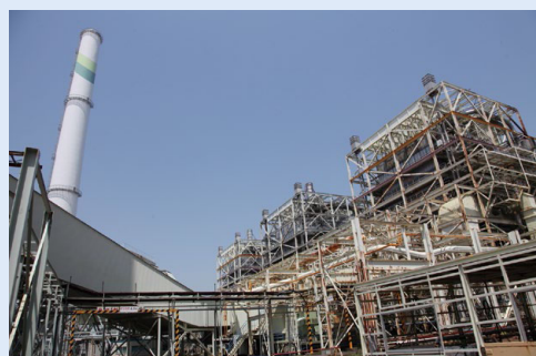
運転開始から約50年を迎えた四日市火力発電所
