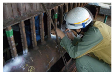
ボイラー設備の点検作業
