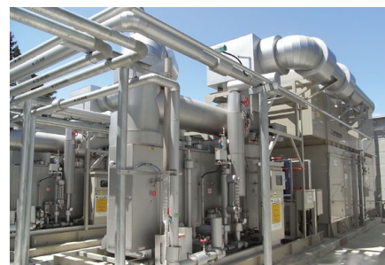
信州ビバレッジ(株)様 ガスコージェネレーションシステム
