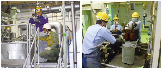
絶縁油リサイクルセンターにおける点検作業
