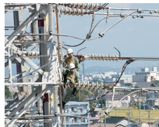
鉄塔上での点検作業
