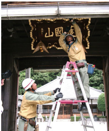
金剛寺(三重県尾鷲市)の電気設備点検
