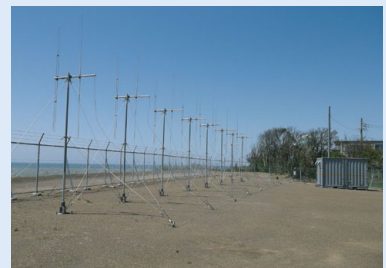
設置したアンテナおよび観測所
