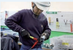
引込線解体作業
