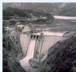
井川水力発電所(1957年)
