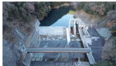
安倍川えん堤
