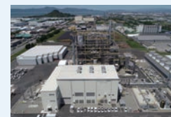
八代バイオマス発電所
