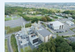
美濃加茂バイオマス発電所
