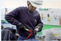
引込線解体作業
