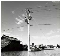
伊勢湾台風での配電線路の復旧 工事(1959年)
