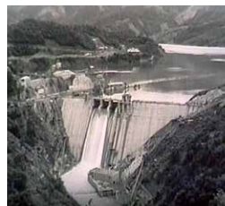
井川水力発電所(1957年)
