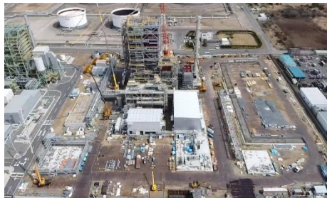
神栖バイオマス発電所 (工事状況)
