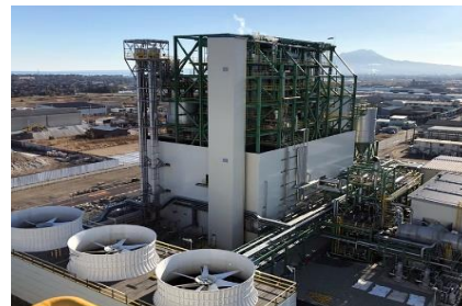
米子バイオマス発電所 (2022年4月運転開始)
