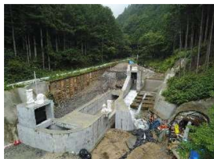
清内路水力発電所 (建設状況)
