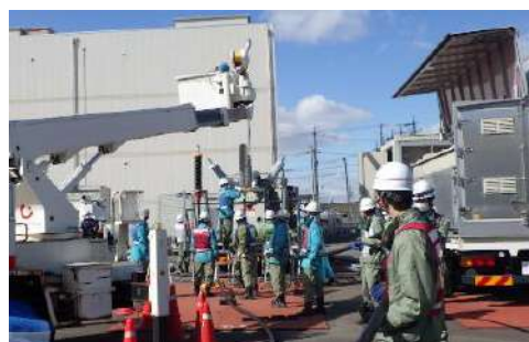
移動式変電所へのケーブル繋ぎ込み作業
