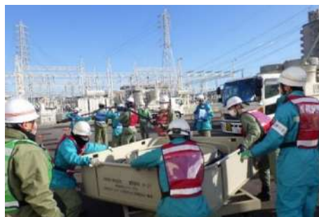
接続用ケーブルの設置作業
