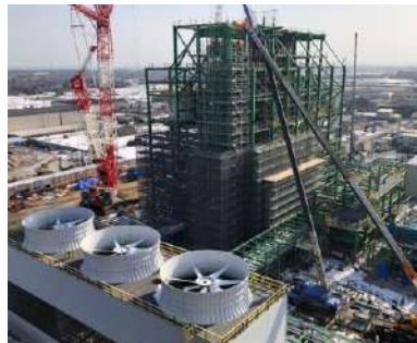
米子バイオマス発電所 (建設状況)
